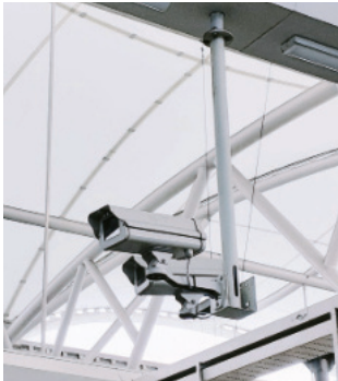
Überwachung mit IP-Kameras
